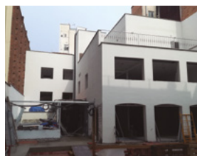
Obres de la futura seu, al districte de Gràcia.
