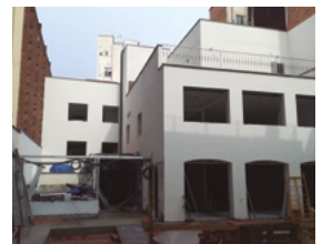
Obras de la futura sede, en el distrito de Gràcia.
