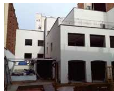
Obras de la futura sede, en el distrito de Gràcia.
